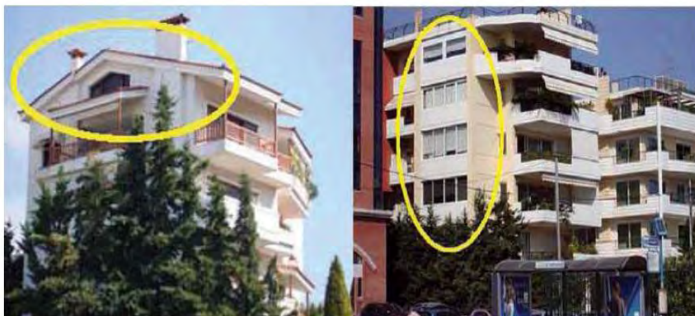
شکل ۱. تخلفات ساختمانی در ساختمان‌های مجلل یونان
