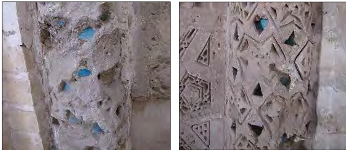
شکل ۲۴. الف و ب: چگونگی فرارگیری آرایه تلفیقی آجر، لعاب و گچ در داخل مقبره خواجه اتابک Fig. 24: Interior architectural decoration of Khaje Atabak mausoleum, Kerman
