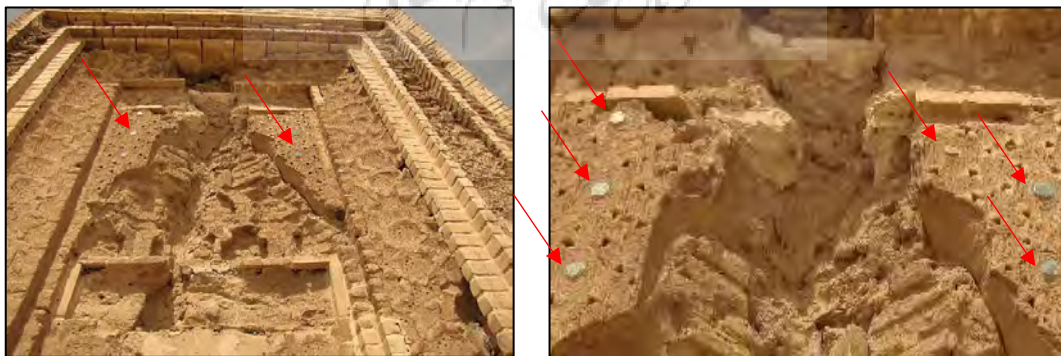
شکل ۲۵. نره کاشی‌های تراش خورده به شکل دایره در نمای بیرونی مقبره خواجه اتابک Fig. 25: Turquoise tiles in exterior Superficies of Khaje Atabak mausoleum, Kerman
