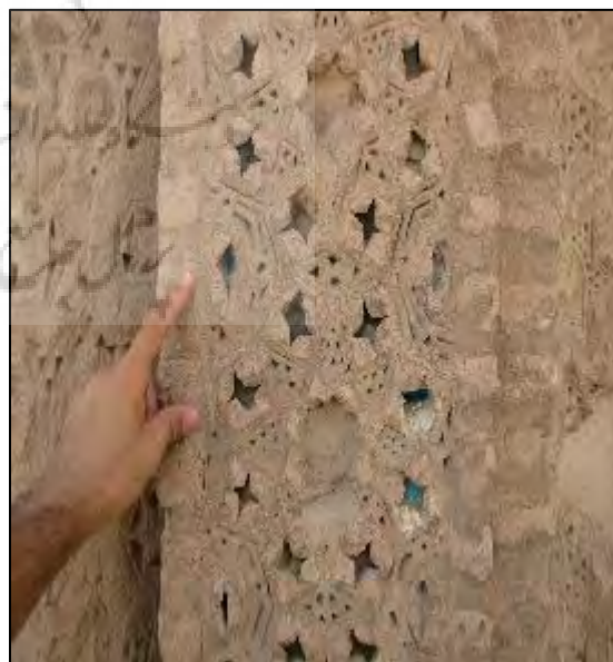
شکل ۲۳. الف: آرایه معماری تلفیق آجر، سفال لعابدار و ملاط گچ در نمای بیرونی مقبره. ب: طرح گره هندسی از بخش الف Fig. 23: Exterior architectural decoration of Khaje Atabak mausoleum, Kerman
