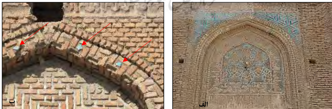
شکل ۱۱. الف: کاشی تکرنگ سردر گنبد سرخ مراغه؛ ب: کاشی تکرنگ کلوک‌بند در میان آرایه‌های آجری گنبد سرخ Fig. 11: Tile works in exterior side of Maraghe Sorkh Dome, Iran.
