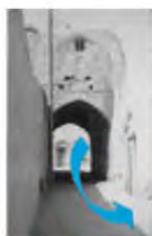
شکل ۱۱- نقش مجاورت دو فضای سرد و گرم (آفتابگیر و سایه دار) در ایجاد نسیم (کلايون، ۱۳۹۳)
