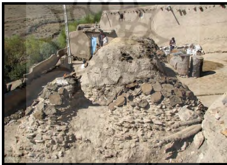
تصویر شماره ۹: نمایی از پوشش گنبدی گرما به داش تپه و شیوه خشک کردن سوخت (نگارنده)
