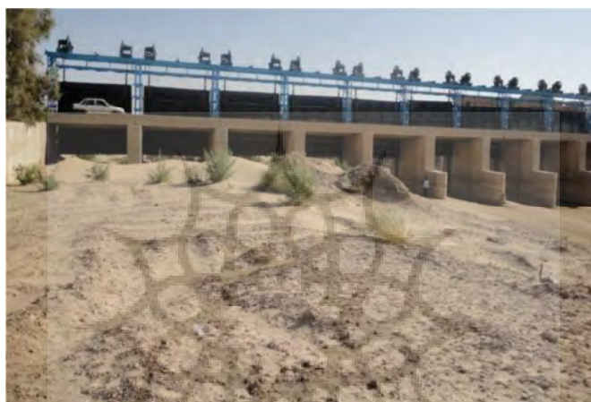
شکل ۲: انسداد بخشی از رودخانه توسط رسوبات بادی، در محل سد کهک
