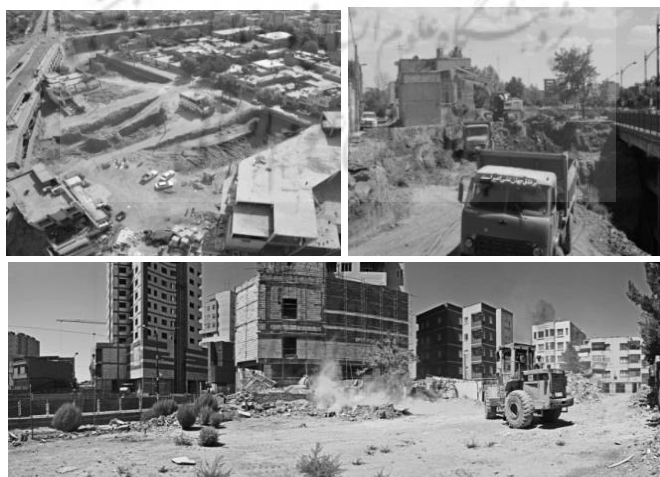
شکل ۶. خاک برداری‌های وسیع و حضور وسایل نقلیه سنگین در محدوده پروژه مجد
