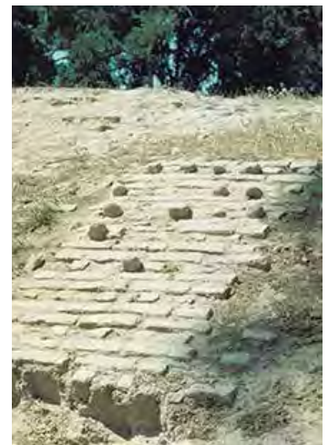
تصویر ۱۸: قلوه‌سنگ‌های کارشده در کف آبشره‌ها (اداره میراث‌فرهنگی شهر فیروزه)
