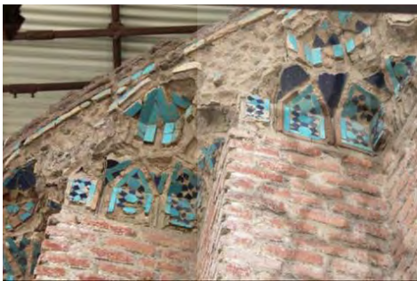
شکل ۱۲: کاشی‌کاری ساقه گنبد، (منبع: نگارندگان، ۱۳۹۶)
