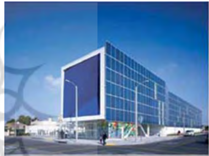
شکل ۱- طراحی نمای یک دبیرستان با استفاده از ۶۵۰ پانل خورشیدی که در مجموع ۷۵٪ نیاز انرژی بنا را تامین می کند (کامل نیا، ۱۳۹۴).
