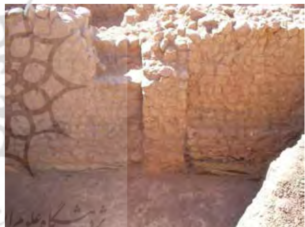
تصویر ۵. شالوده بخشی از دیوارهای ساختار معماری معروف به گرمابه ربع رشیدی بر روی لایه خاک‌روبه و مزبله نهاده شده است. مأخذ: نگارندگان.
