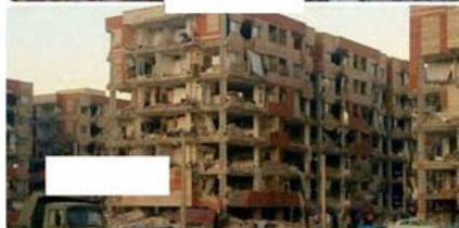
+ تخریب واحد ۵ طبقه (ساختمان غیر از مسکن مهر) در جوانرود (عکس بالا) و خسارت بسیار کمتر واحدهای مسکن مهر سربل نهاب (عکس پایین)
