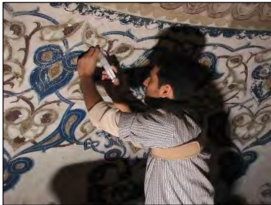
شکل ۶: تزریق ملات در فضاهای خالی بین لایه‌ها و استحکامبخشی لایه‌های آستر و بستر به روش میخ گچی Fig: 6: Injection of mortar in void spaces between layers and strengthening of fine coat and scratch coat Gypsum Nail method
