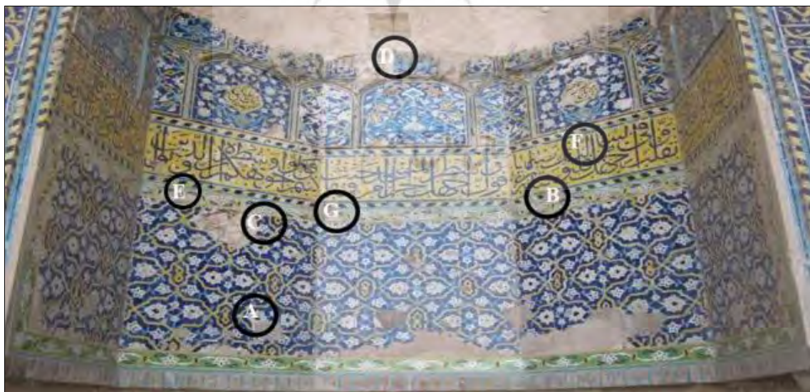
شکل ۸: محل نمونه‌برداری از کاشی‌های معرق اصیل محراب مصلاهی تاریخی مشهد که با دایره سیاه‌رنگ مشخص شده است، (A) رنگ سفید، (B) رنگ سیاه، (C) رنگ آبی لاجوردی، (D) رنگ فیروزه‌ای، (E) رنگ قهوه‌ای، (F) رنگ زرد، (G) رنگ سبز Fig: 8: Sampling location of original mosaic tiles of the mihrab of Mashhad historical Musalla is marked with a black circle, A) White color, B) Black color, C) Blue color, D) Turquoise color, E) Brown color, F) Yellow color, G) Green color
