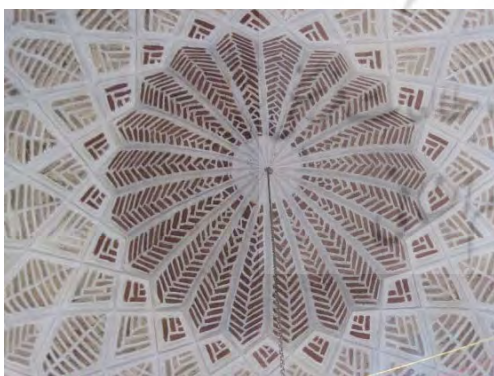
تصویر ۱۱: شمسی‌کاری زیر گنبد امامزاده سراج‌الدین (نگارندگان)
