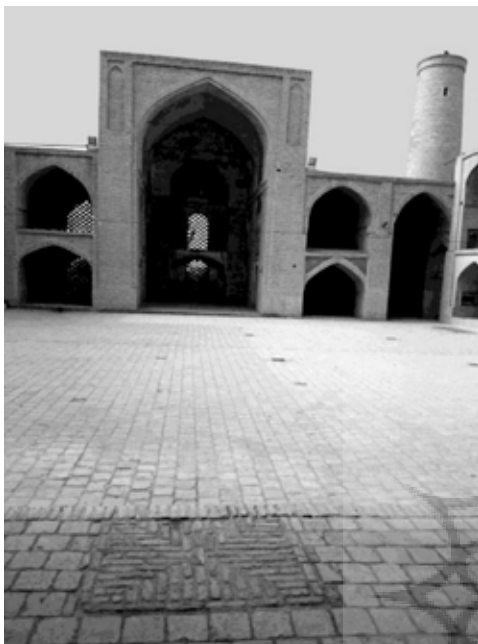
تصویر ۱۷: مسجد جامع اردستان. ردّ ستون مسجد اولیه، واقع در کف میان ایوان شرقی، در مرمت مشخص شده است.
