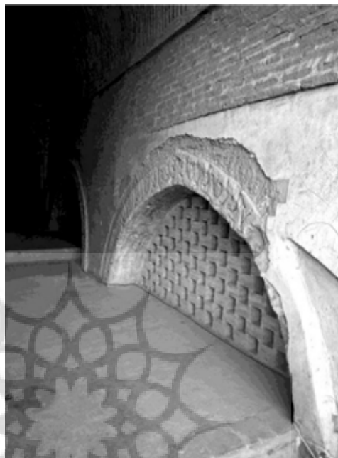
تصویر ۱۶: مسجد جامع اردستان. تویزه‌های مسجد اولیه در ارتفاع بالاتر از زیر لایه‌ها به‌در آمده و در مرمت نشان داده شده است.
