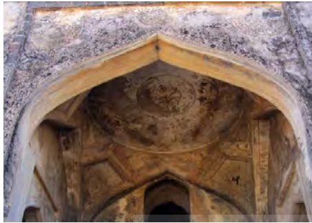
شکل ۱۳: تزئین بالای تیزه‌ی درگاه و منطقه‌ی انتقالی پوشش پیش‌تاق (مردگرد) در کوشک حیاط بهشت‌باغ (مأخذ: همانجا)
