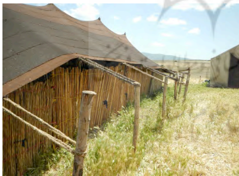
شکل ۸. طناب‌های کوتاه اطراف سه ضلع سیاه چادر
