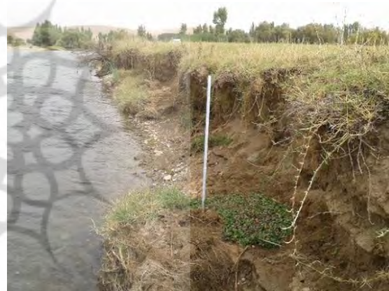
شکل ۱۸ فرسایش کناره ناشی از سیلاب مهرماه سال ۱۳۹۳
