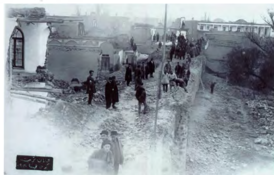
تصاویر ۲ و ۳: پیاده گذر تربیت در زمان احداث (جدیدالاسلام ۱۳۸۶، ۶۵)
