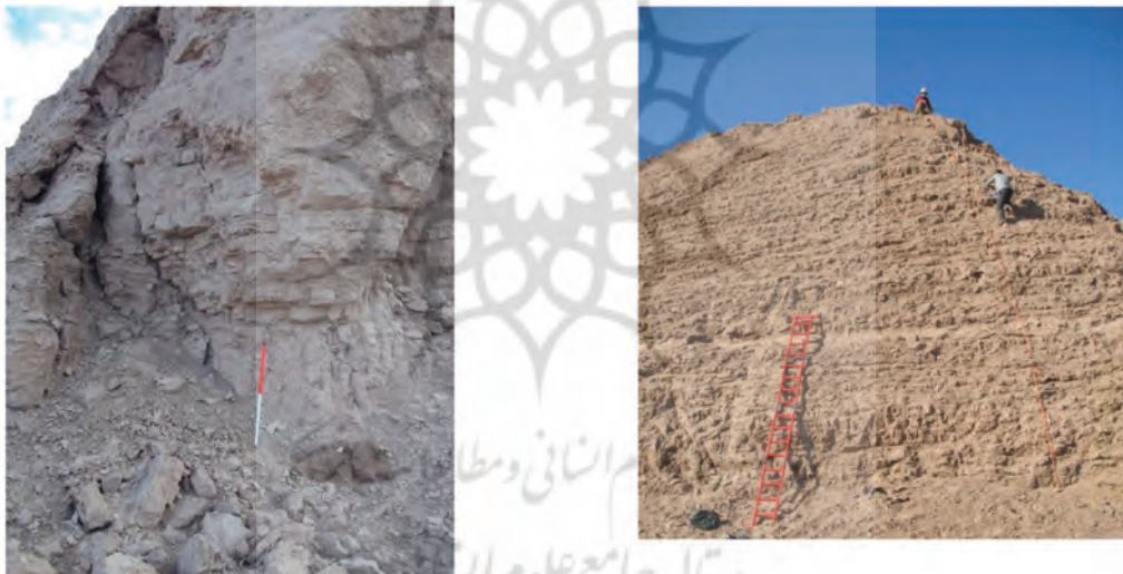
ترانشه شماره ۱ ترانشه شماره ۲
