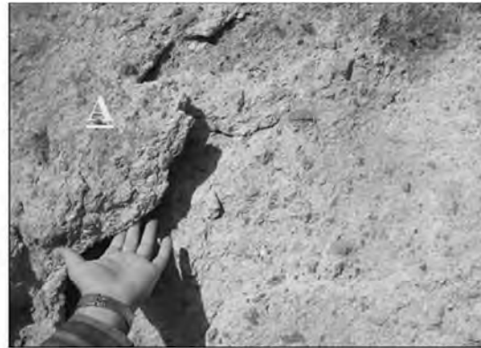
تصاویر ۸ و ۹: برخی گونه‌های شاخص آسیب سنگ در معماری صخره‌ای کندوان. (A) تورق شدید با بیش از ۵ سانتی‌متر جدایش از بستر اصلی. (B) از دست رفتن زمینه (C) تغییر رنگ و تاول (D) جدایش دانه‌ای (مأخذ: نگارندگان ۱۳۹۲).
