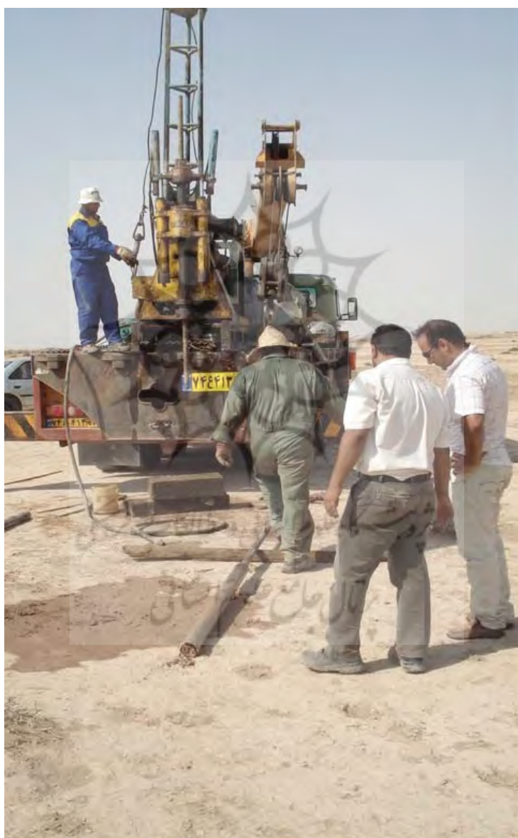
شکل ۴. مغزه‌برداری با مته دورانی در منطقه جفیر
