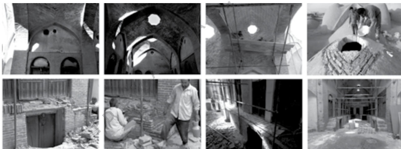
مأخذ تصاویر: آرشیو مجموعه هنر و معماری مهرازان خراب آباد
