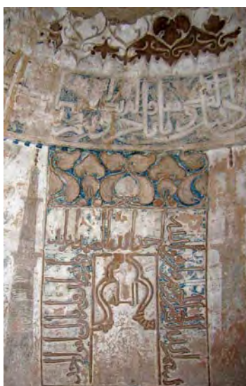
تصویر ۲۱. مقبره پیر بکران (ایلخانی)، نقوش محراب و کتیبه سوره توحید در پایین تصویر و نقوش ساده شده و انتزاعی در بالای تصویر باتکنیک وصله‌ای پیش طرح‌دار اجرا شده است (عکس از ملیحه بکرانی).
