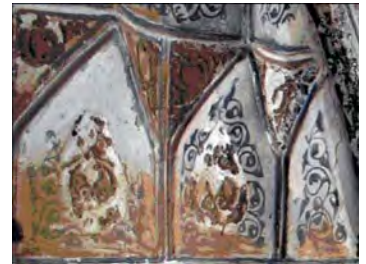
تصویر ۳۱. مقبره سید رکن‌الدین یزد (آلمظفر)، تزیینات رنگی در ترکیب با تزیینات گل‌بری وصله‌ای (عکس از فائزه اصفهانی‌پور).
