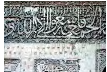
تصویر ۹. تکنیک کچبری برجسته در کتیبه ایوان جنوبی مسجد جامع ورامین
