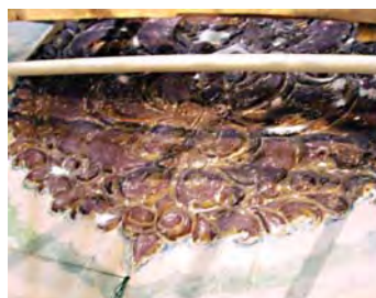
تصویر ۲۴. گنبد سلطانیه، دوره ایلخانی، تزیینات گچی پیش‌ساخته روی پایه پارچه‌ای.
