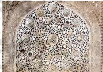
تصویر ۱۲. کچبری مطبق و مشبک محراب مسجد جامع اورمیه
