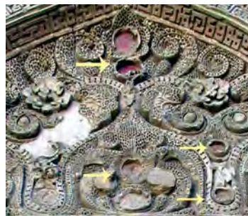
تصویر ۱۵. بخشی از محراب مسجد هفت شیوه، نقاطی که باتکنیک مشبک اجرا شده اند با پیکان مشخص شده، لبه‌های باقی مانده از لایه رویی گچ‌بری مشبک در محیط بیرونی دیوار قرمز رنگ مشخص است
