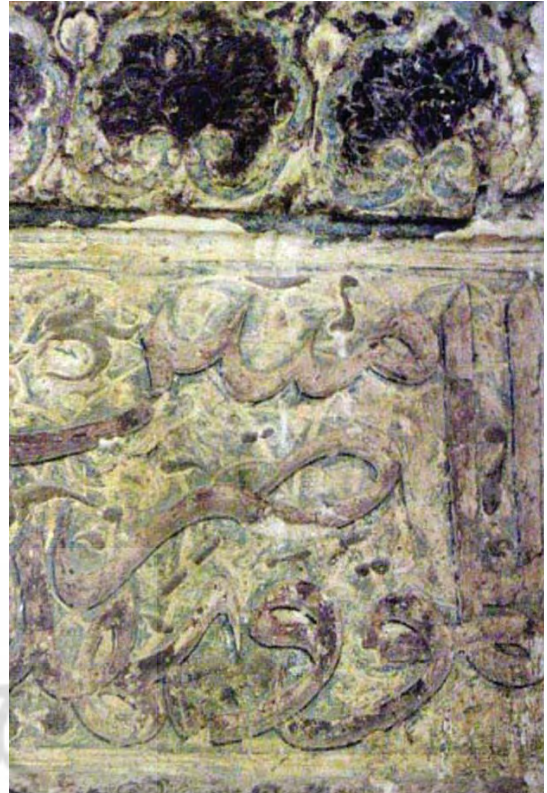
تصویر ۲۲. بخشی از تزیینات وصله‌ای گچ، گنبد سلطانیه. نقش گل نیلوفر باز در قسمت فوقانی تصویر، قالبی و خطوط ثلث تحتانی دستی اجرا شده‌اند. خطوط ثلث روکشی از گل سرخ دارند که احتمالاً با لایه‌ای از طلا پوشیده بودند.
