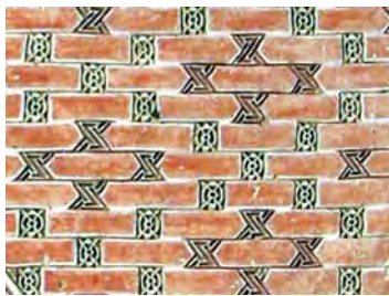
تصویر ۴. گنبد سلطانیه، دوره ایلخانی، تکنیک شبیه‌سازی طرح آجری.
