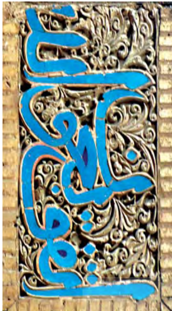
تصویر ۳۳. تلفیق گچ‌بری و کاشی، تزیینات ایوان جنوبی مسجد جامع اشترجان.
