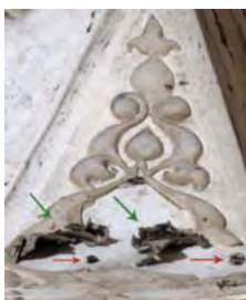
تصویر ۲۵. تکنیک گچ‌بری پته، نواحی میخ‌خورد برای وصل کردن گچ‌بری با پیکان قرمز مشخص گردیده و نواحی که از جای خود جدا شده و تکه‌های پارچه به کار رفته در تهیه این نوع گچ‌بری نمایان شده با پیکان سبز مشخص شده است.
