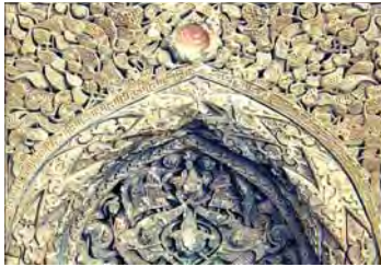
تصویر ۱۳. کچبری مطبق محراب بقعه پیر بکران اصفهان، کچبری مشبک محراب به رنگ قرمز که لایه رویی آن از بین رفته است.
