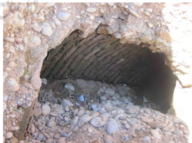
تصویر ۶. قسمتی از سازه‌های جانبی پل. عکس: حسن اکبری، ۱۳۹۲. Fig. 6. Accessory Structures. Photo: Akbari, H., 2013.
