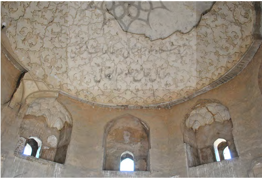
تصویر شماره ۱۳: گچبری‌های باقی‌مانده در نیم‌گنبد درونی آرامگاه
