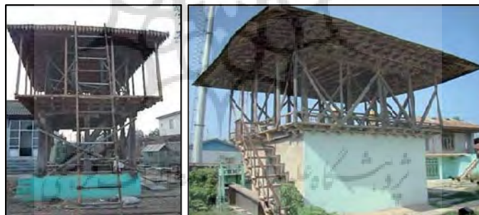
تصویر شماره ۳: سقانفار پاشاکلا تصویر شماره ۴: سقانفار نجارمحل
