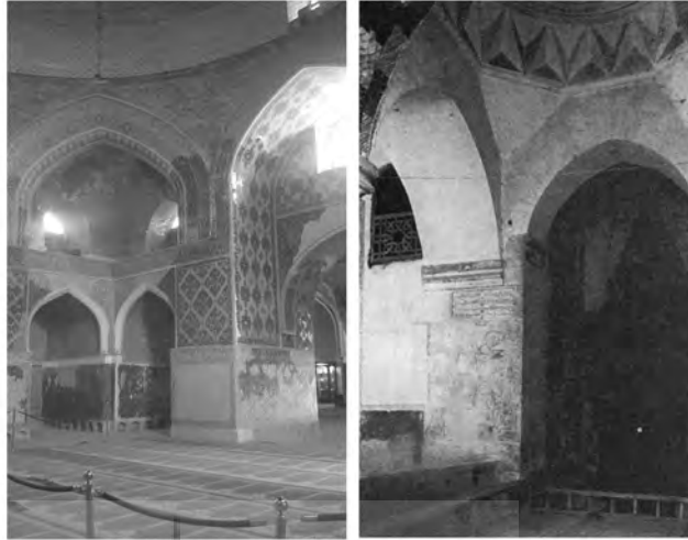
بخشی از فضای داخلی مسجد بایزید پاشا، آماسیه بخشی از فضای داخلی مسجد کبود، تبریز تصویر ۱۸: مقایسه پروفیل منحنی توپزه‌های نمونه منطقه آناتولی (گودوین ۱۳۸۸، ۱۰۴) و مسجد کبود
