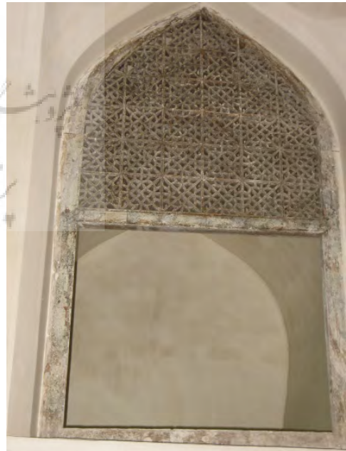
تصویر ۲۷: گره پوک داخل شاه‌نشین عمارت آصف‌دیوان سنندج از آثار دوره صفوی
