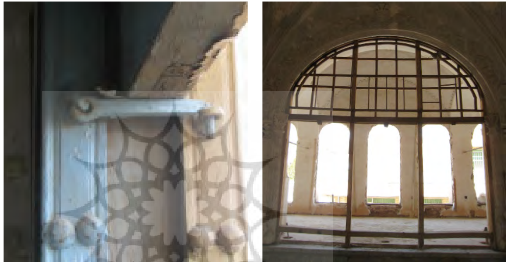
تصویر ۳: چهارچوب اُرسی داخل قصر عمارت خسروآباد در حال مرمت که تمام جزئیات آن باز است. با کتیبه قوس‌دار، وادارها و پاخور یا پاشنه تصویر ۴: نحوه نگهداری لنگه اُرسی عمارت خسروآباد با خروسک فلزی
