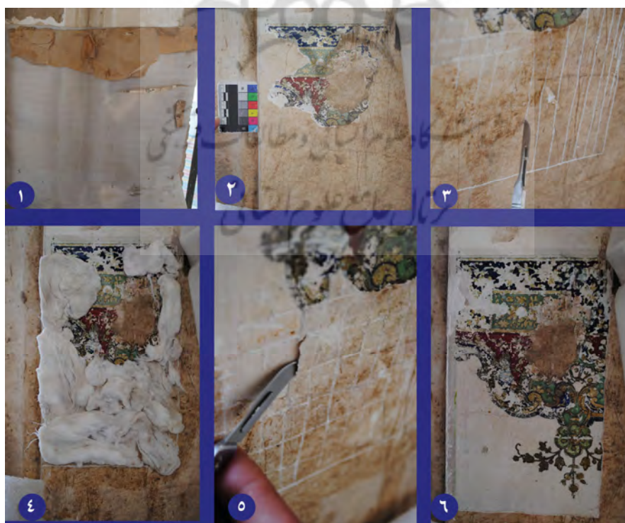
تصویر ۱۲- برداشت لایه‌ی رویی با استفاده از آب مقطر به روش ضماگذاری با پنبه بر اساس مراحل ذکر شده.
