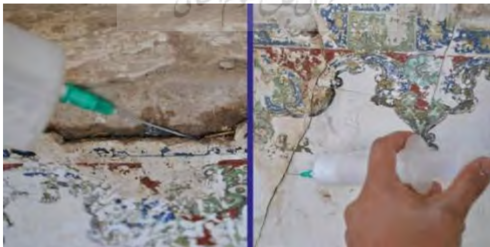
تصویر ۱۶- استحکام بخشی لایه‌ها با تزریق پریمال در زیر لایه‌ها و ترک‌ها.
