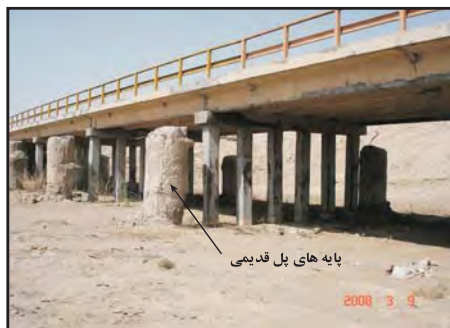
شکل ۹: پایه‌های تخریب شده پل قدیمی احداث شده بر روی رودخانه شور
