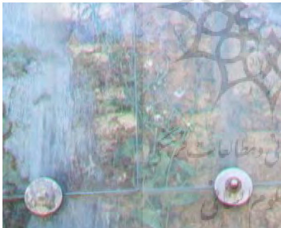
تصویر ۲۹ - سپر حفاظتی و اثرات تخریبی گلخانه‌ای آن (عکسها از آرشیو دیجیتال هفت تپه)
