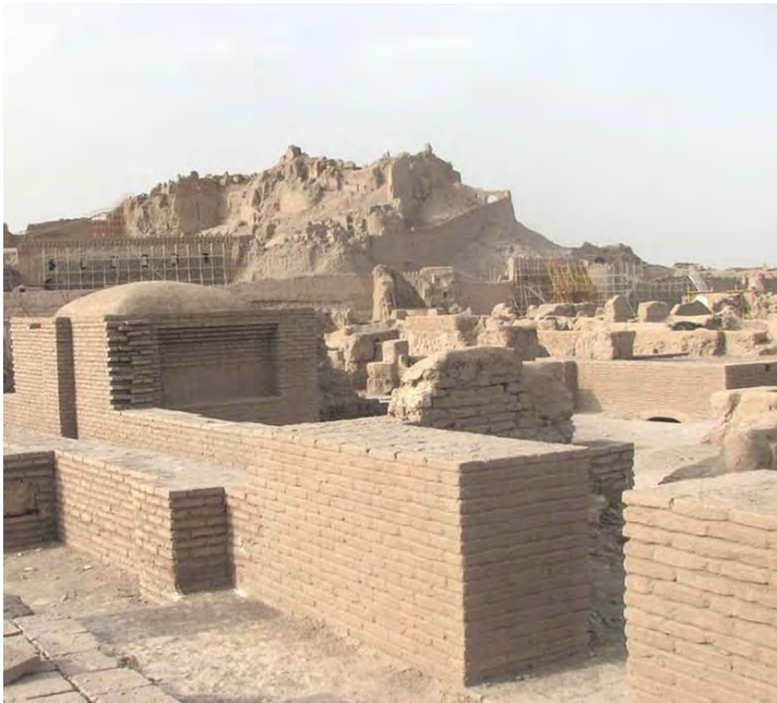
شکل ۱: بخشی از معماری خاکی ارگ بم (بعد از زلزله)
