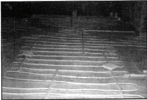
نصب شبکه‌ی لوله‌های پنج لایه پس از عایق‌بندی کف در یکی از فضاهای شمالی خانقاه چلبی‌اوغلو
