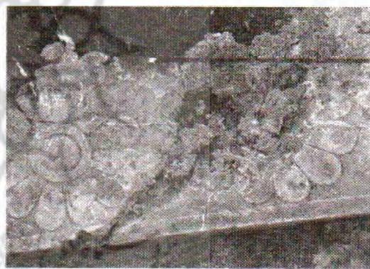
تصاویر ۵ و ۶ رشد گلکسنگ بر روی سنگ در مجاورت ملات ماسه سیمان
