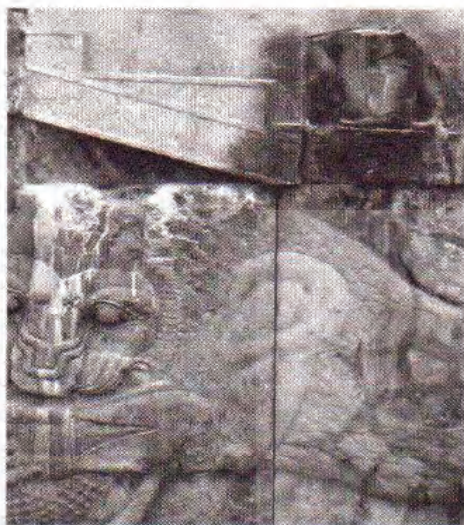
تصویر ۴. کندانه شدن رطوبت در مرز مشترک سنگ و مشترک سنگ و ملات ماسه سیمان ملات ماسه سیمان
