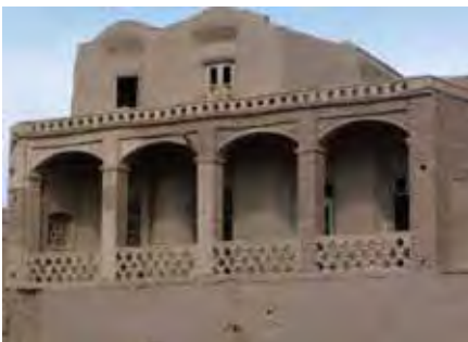
۱: ساختمان‌های متأخر و مربوط به دوره قاجار، مشبک‌های خشتی و آجری برای پنجره، نورگیر و نرده ایوان، عکس: نگارنده، ۱۳۸۹.
