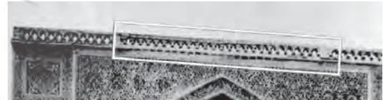
تصویر ۱۰- کنگره‌های آجری در پیشانی یکی از ایوان‌های مسجد جامع یزد از دوره سلجوقی، ماخذ: ماهرالنقش، ۱۳۶۲، ۸۴
