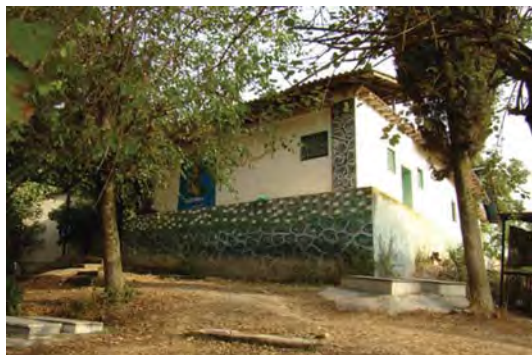
تصویر ۳۰- نمای بیرونی بارگاه. بنای تازه ساز با پلان مستطیلی بر روی سکویی واقع شده است. فضای بیرونی آن را با نقوش گیاهی و اشکالی انتزاعی از سنگ تزئین کرده اند. ساری.
