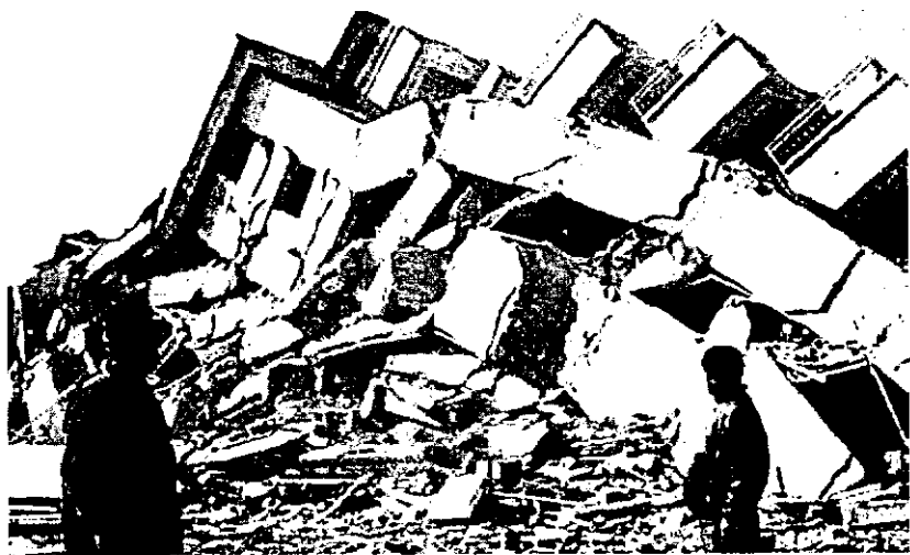
شکل ۱. خرابی ناشی از زلزله
