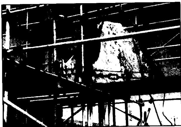
نصب و تنظیم سنگهای ستوری ضلع شمالی و جنوبی در محل اصلی خود
