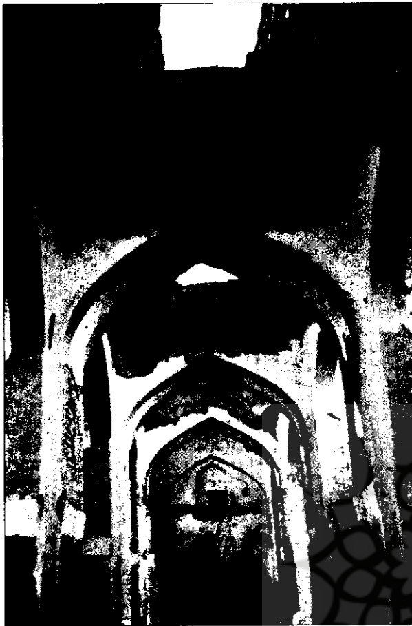
تصویر ۷- نمای داخلی شبستان جبهه شرقی مسجد آق قلعه سبزوار
