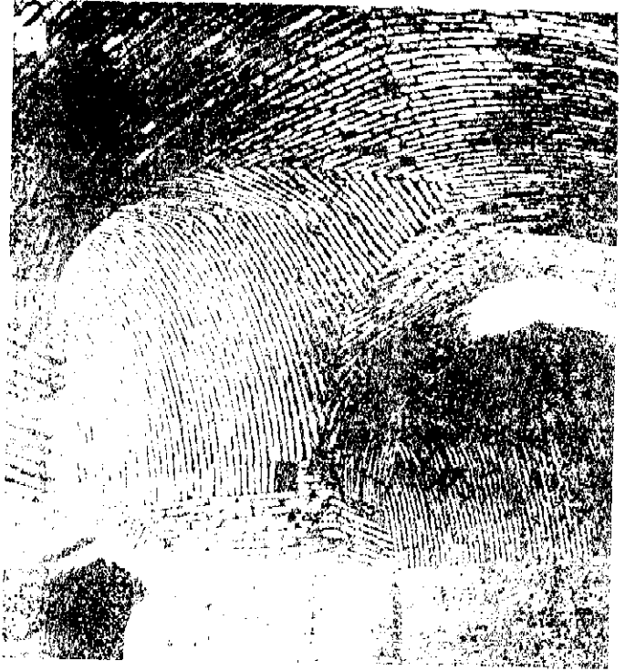
۱۶- پوشش‌های زیبای اصطبل‌ها و سوراخی که در سقف موجود آمده است.
