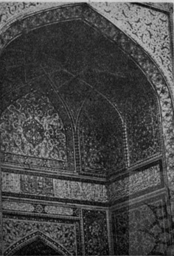
شکل ۳۱ - مدخل بنای هارون ولایت اصفهان مورخ ۹۱۸ هجری که يك گوشوار موزائیکی را با قوس جناغی تیز نشان میدهد
