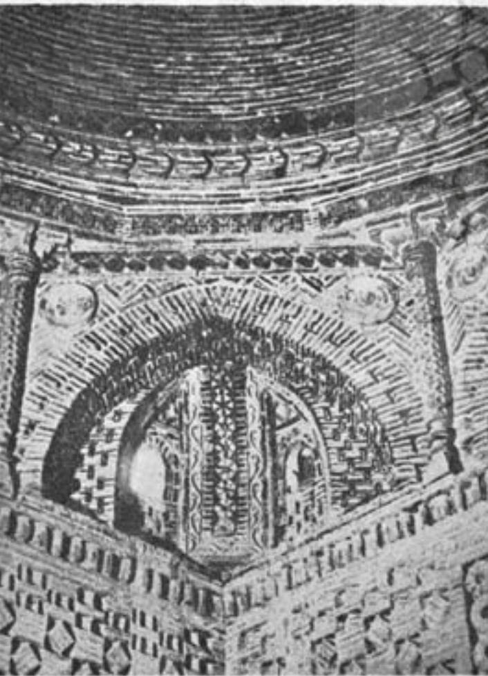
شکل ۶ - داخل مقبره شاه اسماعیل ساسانی در بخارا مربوط به آخر قرن سوم هجری که گوشوار وقتی از منظره تغییر حالت از مربع به مدور را نشان میدهد
