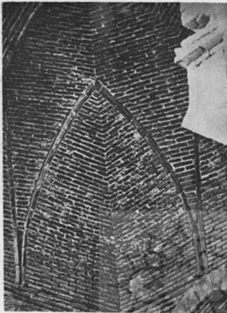
شکل ۱ - پلان چهارطاقی نیزار مربوط به دوره ساسانی که هر طرف آن يك درگاه دارد شکل ۲ - گنبدی از مسجد جامع اصفهان مربوط به دوره سلجوقی که طرز ساسانی، بین ایوان و تالار مربع آن سه درگاه وجود دارد شکل ۳ - گنبدی از مسجد جامع اصفهان مربوط به دوره سلجوقی که طرز قرار گرفتن آجرها را نشان میدهد
