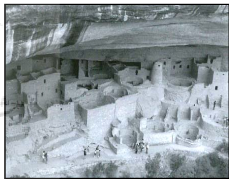
تصویر ۱۵. مساورد، کلرادو، استفاده از ظرفیت جذب گرمایی صخره‌های سنگی و دیوارهای ماسیونری، مأخذ: Norbert lechner,2001: 251.
