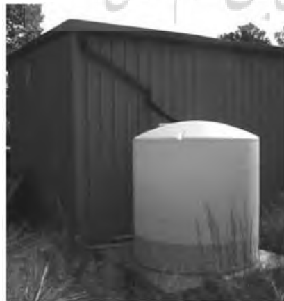
شکل ۳ نمایی از آبخیز پشت بام و مخازن سطحی و زیرزمینی احداث شده جهت نگهداری آب جمع‌آوری شده.
