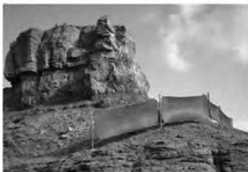
شکل: صفحات مشبک نصب شده در جهت عمود بر جریان باد جهت جمع‌آوری آب مه و هدایت آن به منبع تعبیه شده بوسیله یک سیستم ساده لوله کشی.
