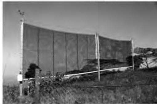
شکل: صفحات مشبک نصب شده در جهت عمود بر جریان باد جهت جمع‌آوری آب مه و هدایت آن به منبع تعبیه شده بوسیله یک سیستم ساده لوله کشی.
