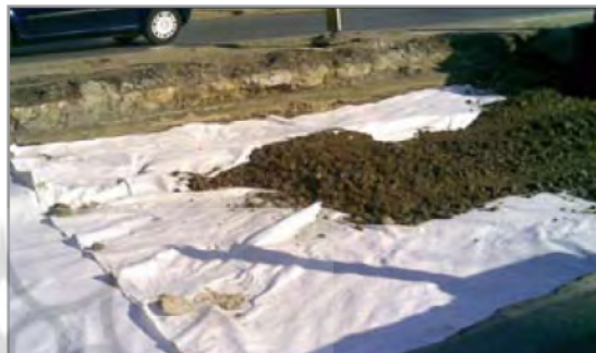
شکل ۴- استفاده از ژئوتکستایل برای جداسازی خاک
