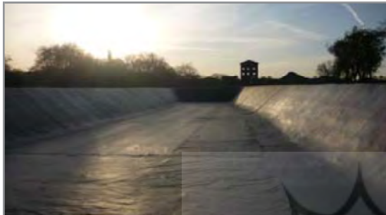
شکل ۶- استفاده از ژئوممبرین برای آب‌بندی کف کانال
