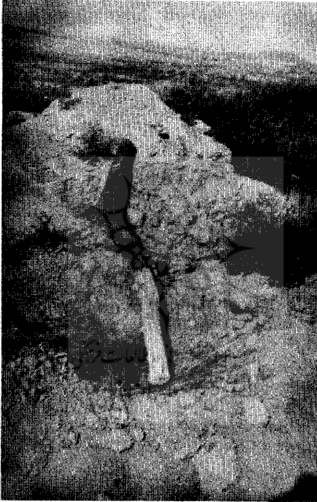
میلم یا ممانع چوبی است به درازای ۱۸۷ سانتیمتر که سمت پایین و گرد آنرا در سوراخ سنگی خان استخر فرومی‌برند و جریان خروج آب استخر را قطع می‌کنند.
