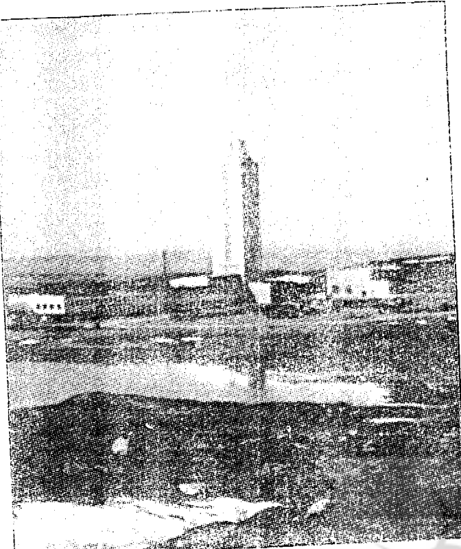
نظر بر ۲ - جایگاه دال بنایی به بلندی ساختمانی ۳۰ طبقه است. به در تندر ای کولاً ۲۵۰ کیلومتری شمال دایره شمالگان واقع است. این ساختمان، تاسیسات روی جاه را از یخ زدن حفظ می‌کند و شرایط را برای حفاری در طول تمام سال فراهم می‌آورد.
