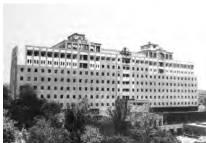
تصویر ۱۹ - ساختمان نمایندگان مجلس. شیوه: پست مدرن ایرانی با رجوع به معماری قاجار کارفرما: مجلس شورای اسلامی معمار: مهندسین مشاور باوند (منبع: بانی مسعود، ۱۳۸۸، ۴۶۲) (مأخذ تصویر: همان)
