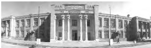
تصویر ۱۲- مدرسه انوشیروان. شیوه: نئوکلاسیک با رجوع به معماری هخامنشی کارفرما: بانوی خیر زرتشتی، معمار: مارکوف (منبع: دانیل، ۱۳۸۲، ۶۸) (مأخذ تصویر: بانی مسعود، ۱۳۸۸)
