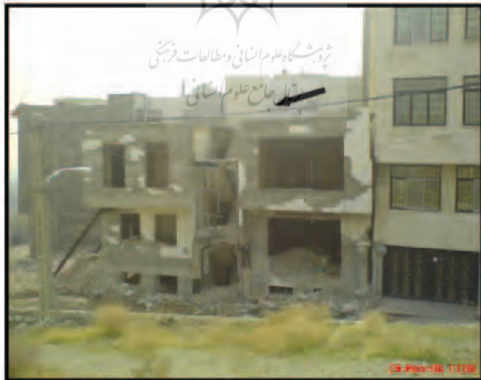
شکل ۲۴. واحد مسکونی (شکل ۲۳) لغزش یافته در دره فرحزاد (شهرک مجلس) - تخریب نسبی
